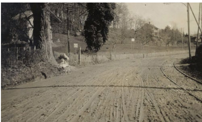
Fig. 15: Route Veynes sur Lausanne 1910
